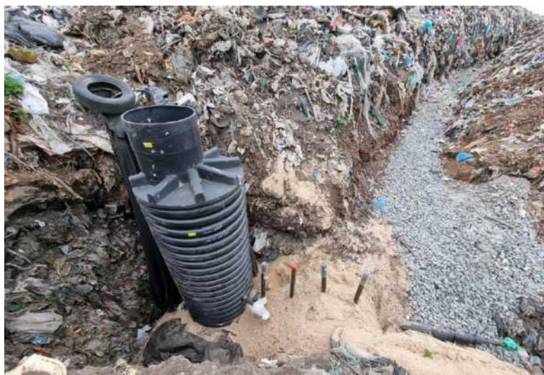
12 pav. nudojinimo sistema Šiaulių regiono nepavojingų atliekų sąvartyno III sekcijoje
