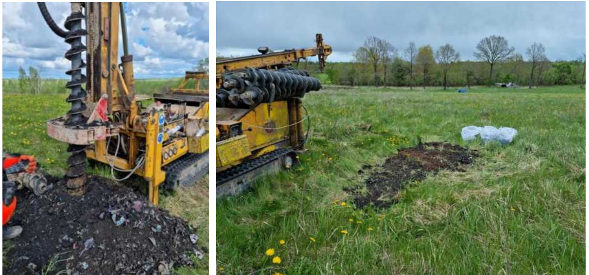
18 pav. uždarytame Aleknaičių sąvartyne atliekami bandomieji tyrimai-kasinėjimai
