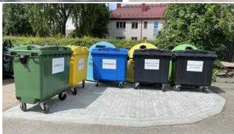
2 pav. Pakruojo r. savivaldybės teritorijoje antžeminių konteinerių aikštelių rangos darbai
